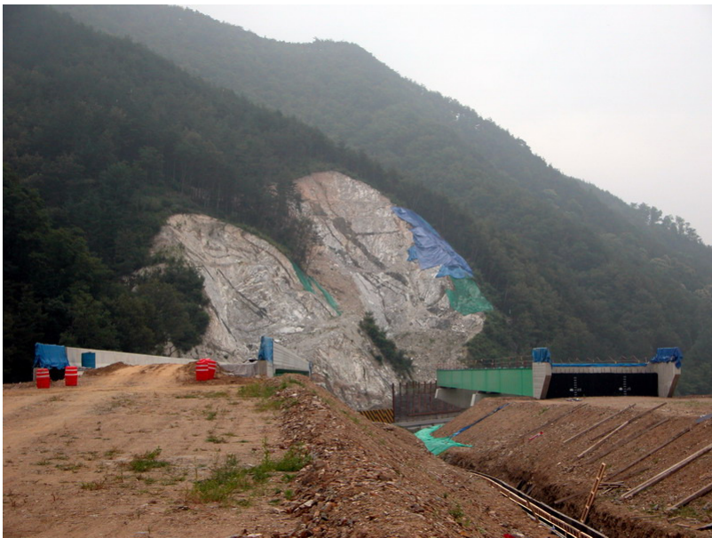
사진 11 터널 공사를 하고 있는 3번국도 산청~수동 공사현장 모습
