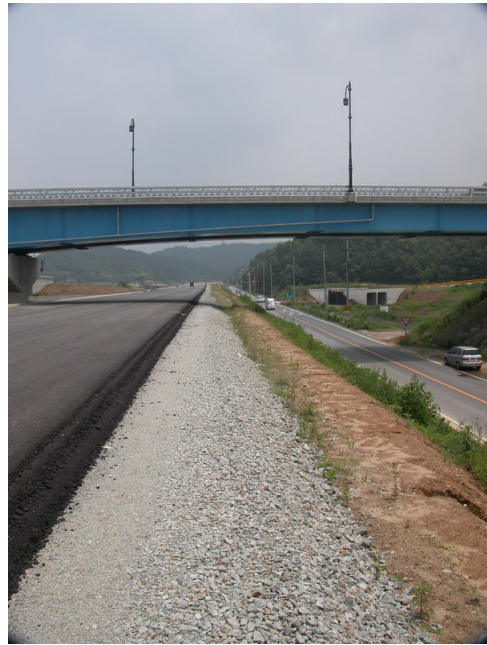
사진 13 부여~탄천 40번국도 공사현장
