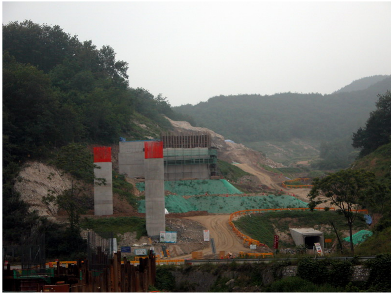
사진 10 산청~수동구간 3번국도 확장공사 현장
