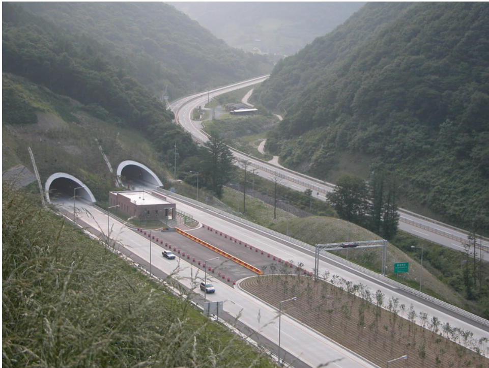
사진 4 중부내륙고속도로 문경새재 터널과 3번국도 이화령터널 모습
