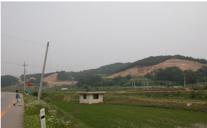
사진 9 산을 파헤치며 공사를 하고 있는 5번국도 안동~영주 확장 공사 현장
