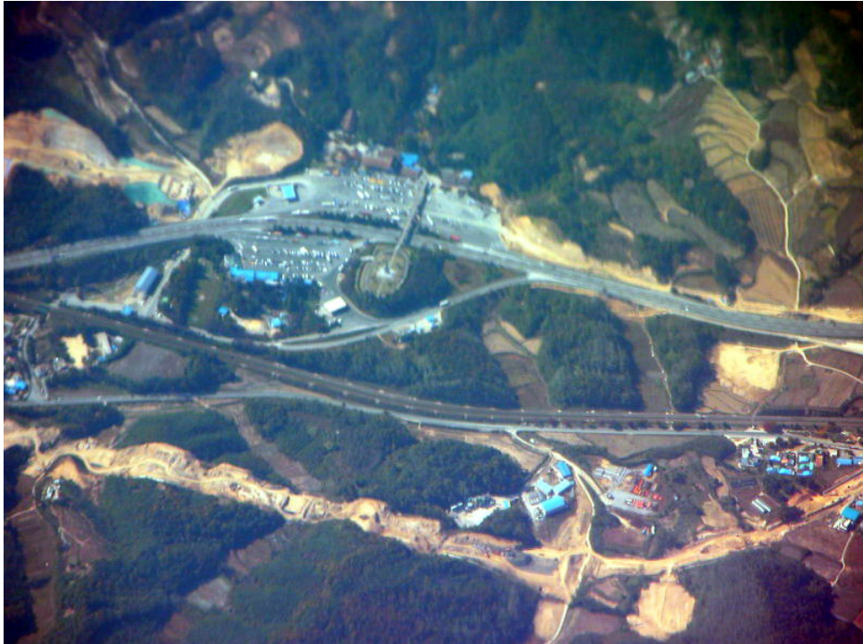
사진 18 4번국도 추풍령 구간 확장공사 현장 항공 촬영 사진
