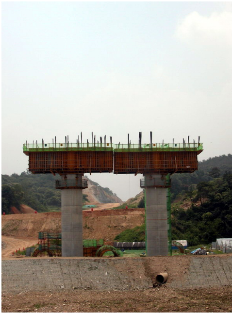
사진 12 공주~서천 고속도로 공사현장
