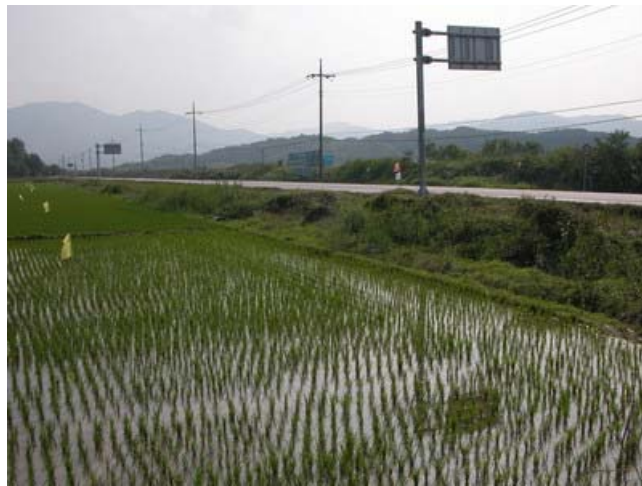
사진 6 논에 꽃혀있는 국도확장공사 구역 표시 깃발
