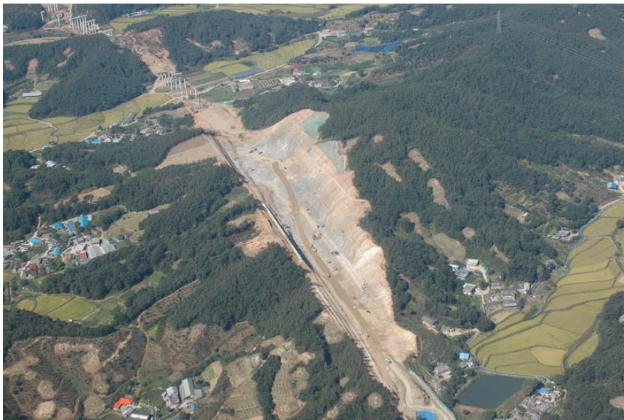
사진 5 대전~당진 고속도로 공사 현장 항공 촬영 사진
