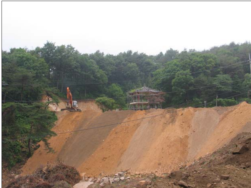
그림23. 박달재 옛 도로의 공사 현장
