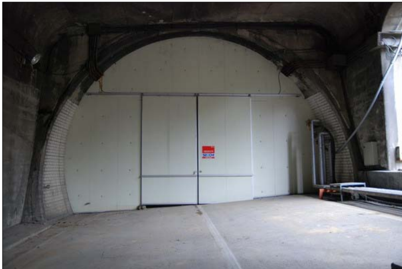
그림27. 폐옥천터널을 이용한 김치숙성고 전경
