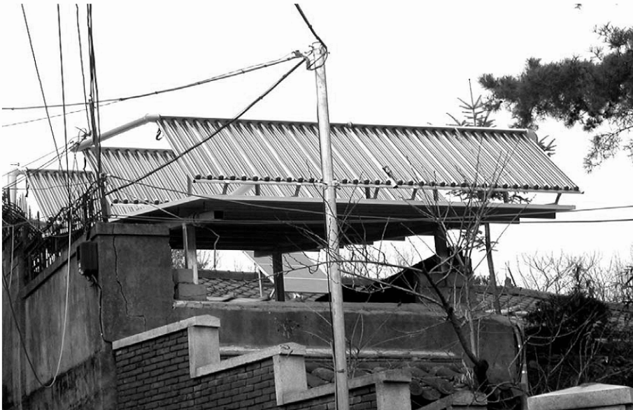
그림 25. 태양열 급탕기가 설치된 사례 - (구) 에너지 대안센터
