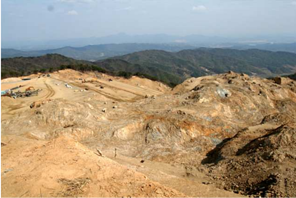
그림 3. 토석 충당을 위해 개발 중인 상부댐의 석산, 공사가 완공되면 이 산은 완전히 사라지고 공원이 만들어진다.
