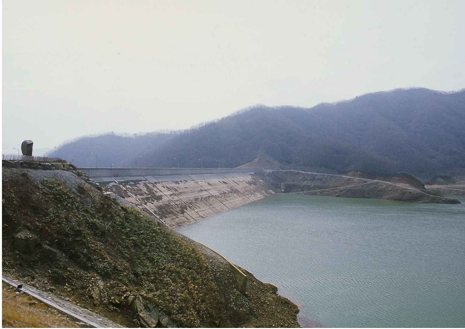
그림 13. 산청 양수발전 상부댐, 외벽 너머는 지리산 고운동 계곡이다.
