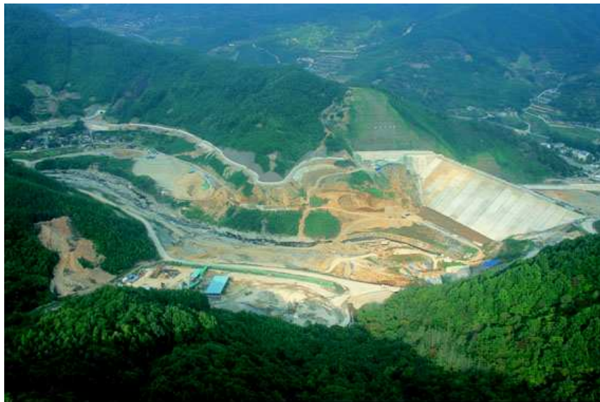
그림 14. 산청 양수발전 하부댐 공사 중인 모습, 아름다운 내대계곡의 모습은 찾아볼 수 없다.
