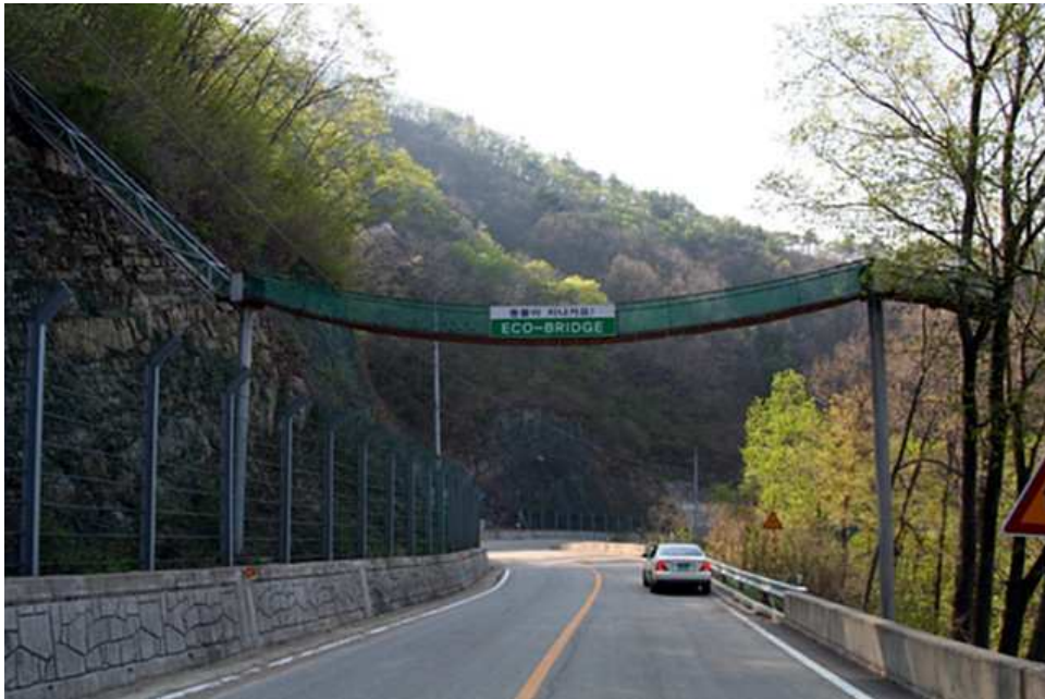
그림 8. 상부담 진입 도로에 설치된 작은 동물을 위한 파이프형 이동통로, 절개지의 급경사로 실효성이 의심된다.
