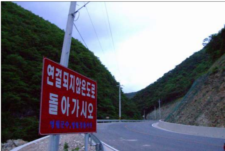
그림 24. 도로가 끊겼다는 것을 알려주는 세송~어평간 도로
