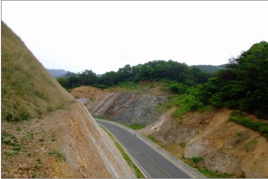
그림 9 .절개면의 높이가 20M에 이르는 작곡~우래간 도로
