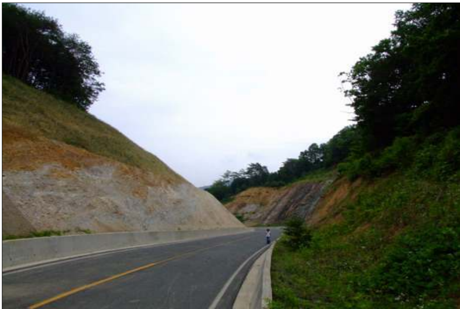
그림 10. 200M의 산을 절개한 작곡~우래간 도로
