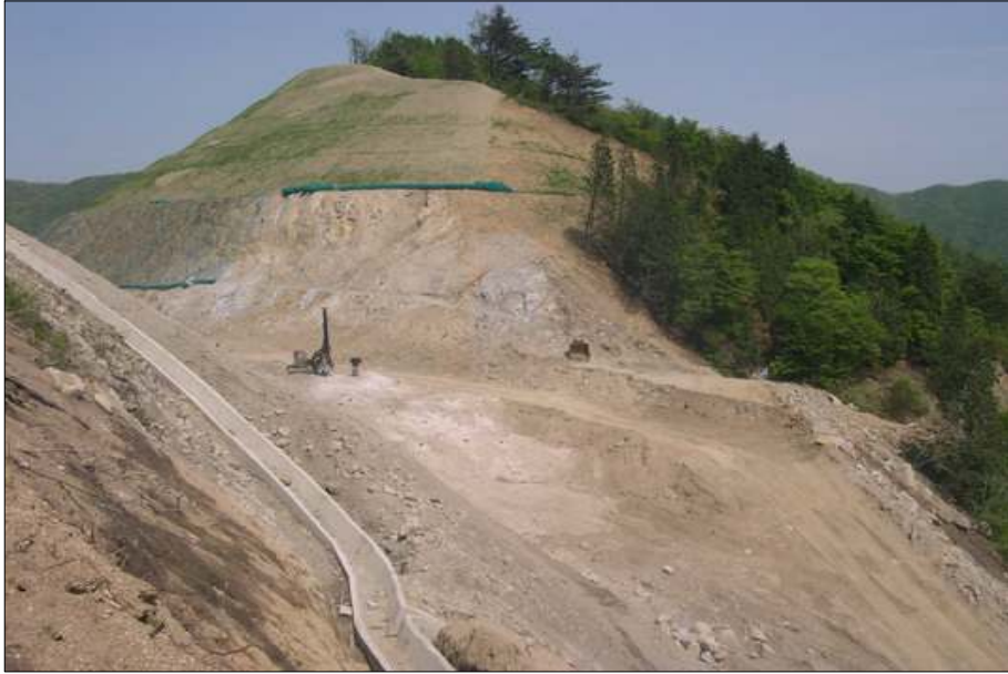
그림 6 . 고갯마루를 절개하여 만들고 있는 구성~신평간도로
