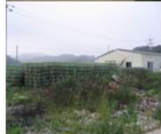
연평도 내 방치된 폐망폐기물(과거엔 2005)
