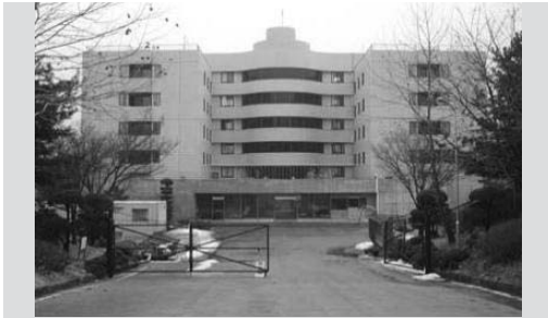
▲ 매편관(여학생기숙사)지열냉난방 용량 : 200RT / 공사시기 : 2005.10~2005.12
