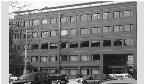
▲ 창업보육센터(교수연구동) 지열냉난방 용량 : 120RT / 공사시기 : 2006.10~2006.12
