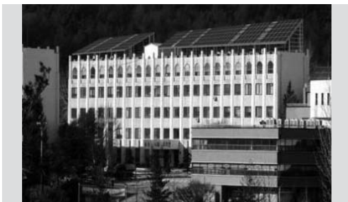
▲ 응용동물과학관 태양광 발전 용량 : 50KW / 공사시기 : 2008.5~2008.10
