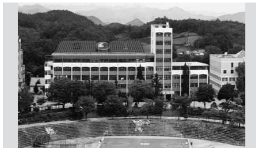
▲ 예술관 태양광 발전 용량 : 50KW / 공사시기 : 2007.9~2007.11
