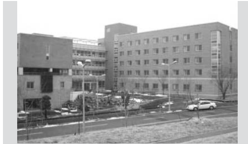
▲ 매편관(남학생기숙사)지열냉난방 용량 : 200RT / 공사시기 : 2006.8~2006.12
