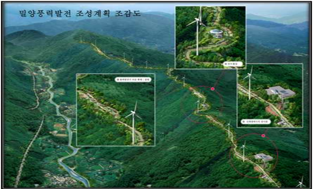
그림 11 영남 알프스 풍력발전단지 건설 조감도. 마루금을 따라 건설될 풍력단지의 모습이 뚜렷하게 보인다.
