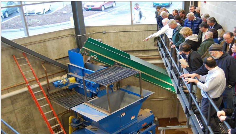
학교에 설치된 바이오가스 생산 공장
