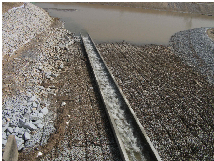
그림 16 여주 소양천 하류부 콘크리트 수로
