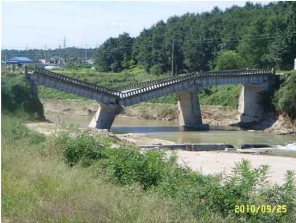
그림 12 여주 신진교 붕괴 모습
