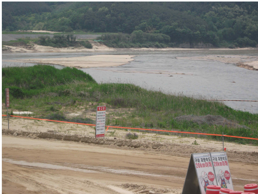
그림 17 낙동강과 황강의 합류점에서 준설후 재퇴적되는 모습
