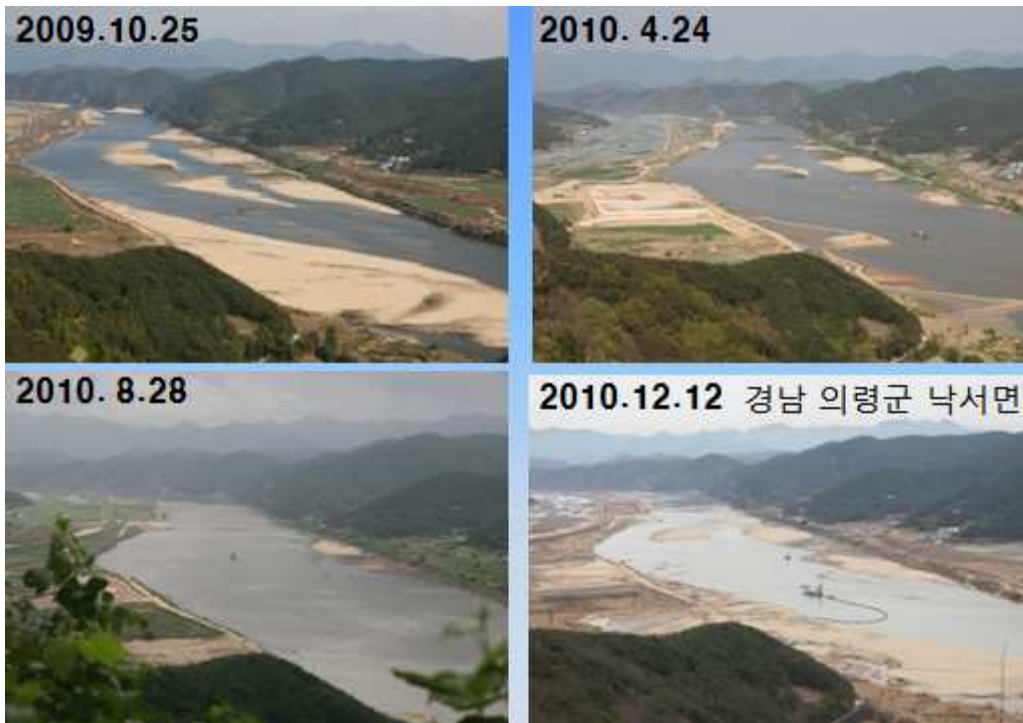
그림 18 경남 의령군 낙서면 준설 현장(자료 : 내일신문 남준기)
