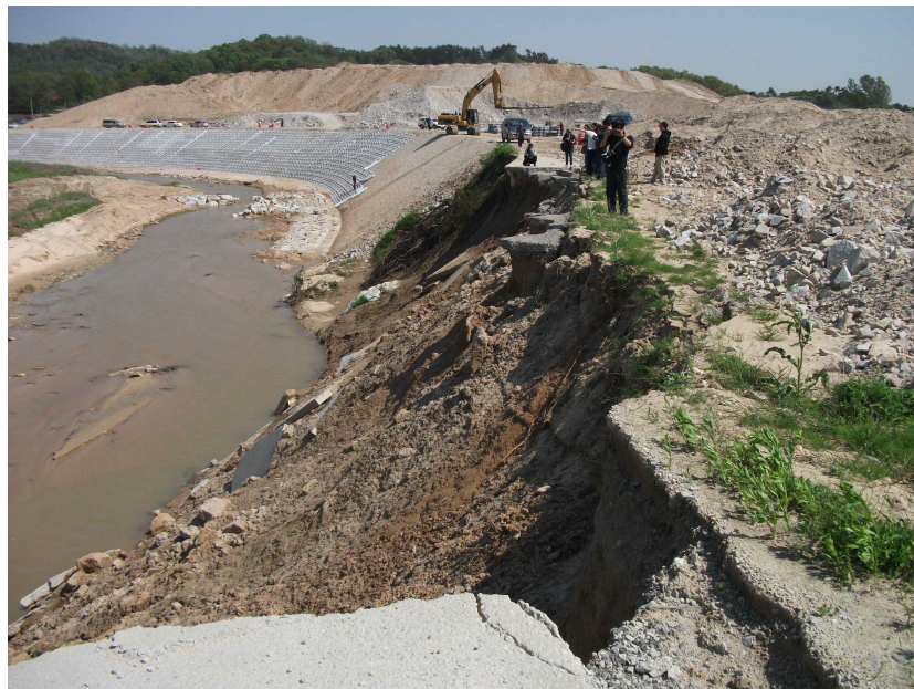
그림 21 여주 한천 콘크리트 제방도로 유실
