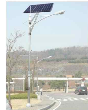
태양광발전 가로등 설치
