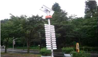
태양광 계시판 설치
