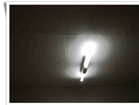
바람이 들어오던 천정과 벽은 단열재(열반사, 석고보드)로 마무리
