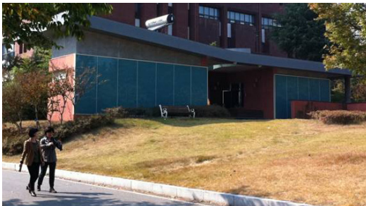
대구대 공중화장실 태양열 시설
