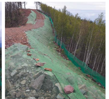
영광 양구리 · 흥계리 풍력단지 공사현장
