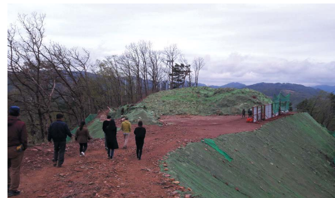
영광 양구리 · 흥계리 풍력단지 공사현장
